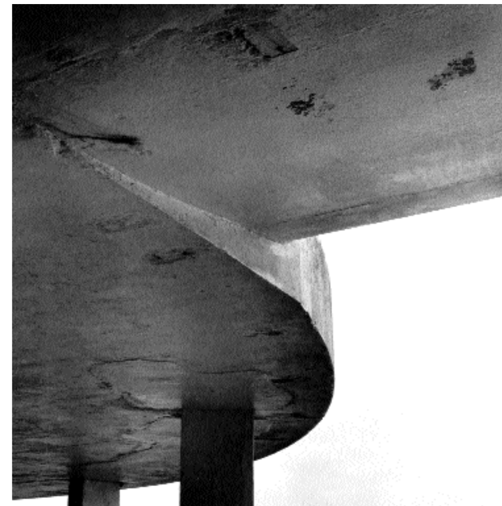
Akce bez názvu (betonový strop držený pilíři) čb fotografie na papíře, 15,5x15,5 cm, Hastings, Anglie 1995
